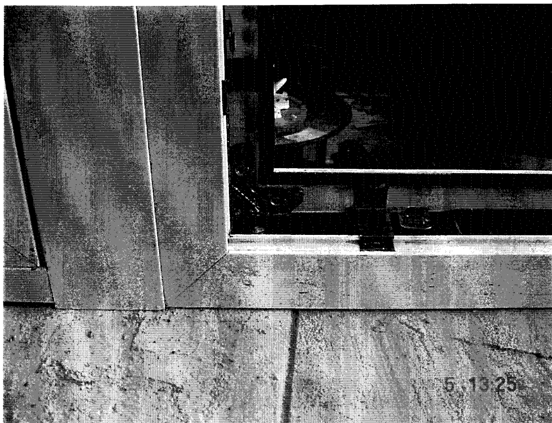
Foto 1 Detail glasklipsen en oplegging beglazing
